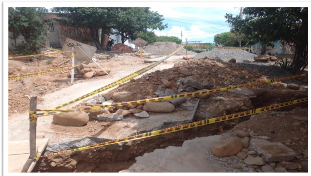
Reposición de redes de acueducto y alcantarillado Barrio Santander
