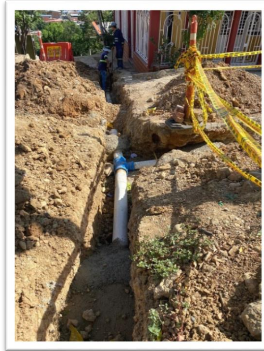
Reposición de redes de acueducto y alcantarillado Barrio Santander
