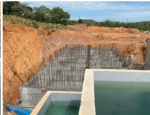
Fotografía No.35 y 36 Cámara de contacto de cloro. Fotografías tomadas el 27 de septiembre
