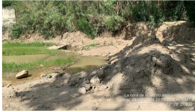
Fotografía No. 2, estado actual desarenador Fotografía No. 2 estado actual empalme desarenador. Fotografías tomadas el Jueves, 24 de octubre
