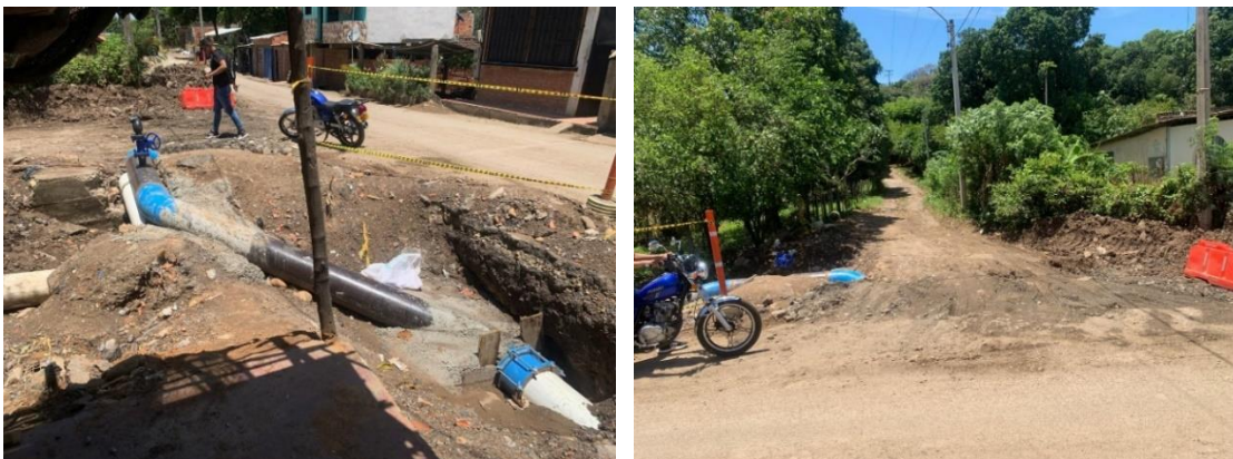
Fotografía No. 9. Estado actual paso No. 4 /Fotografía No.10. Accesorio expuesto calzada paso No. 4
