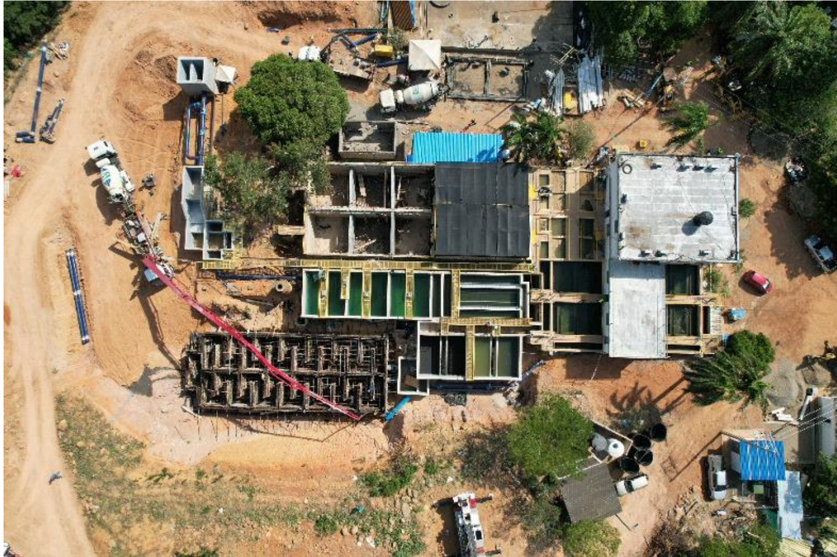
Fotografía No.25, Sector de la PTAP donde se están ejecutando las obras.
