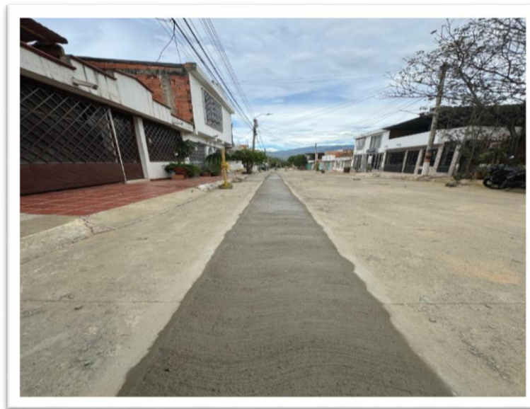
Ejecución Proyecto Barrio Los Trapiches – Reposición estructura del pavimento
