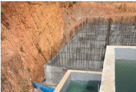
Fotografía No.35 y 36 Cámara de contacto de cloro. Fotografías tomadas el 27 de septiembre
