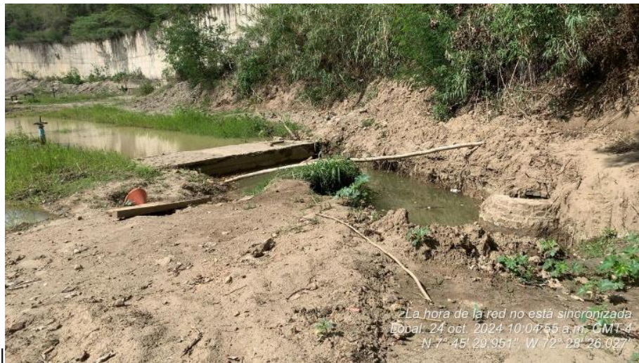
Fotografía No. 1 estado actual desarenador Fotografía No. 2 estado actual empalme desarenador. Fotografías tomadas el Jueves, 24 de octubre
