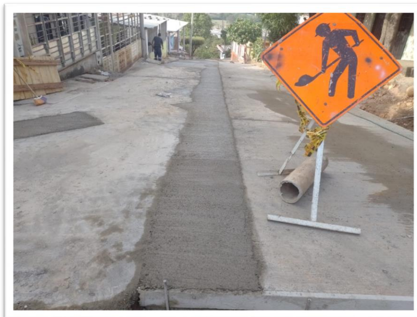
Reposición de redes de acueducto y alcantarillado Barrio Santander
