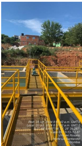
Fotografía No.5 Floculador nuevo terminado Fotografías tomadas el 25 de octubre
