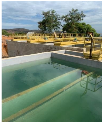
Fotografía No.33 y 34 filtros nuevos y filtros existentes. Fotografías tomadas el 27 de septiembre
