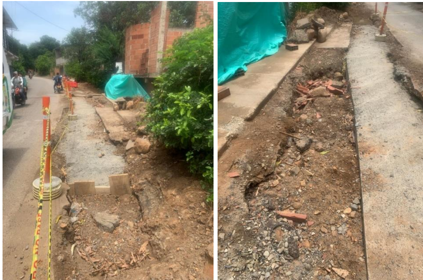
Fotografía No.11 y 12. Paso especial No. 5.terminado falta recuperación del pavimento
