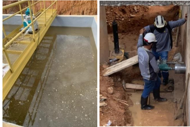
Fotografía No.30 y 31 Floculador nuevo, y perforación tanque existente para empalme con la cámara de distribución de caudales. Fotografías tomadas el 27 de septiembre
