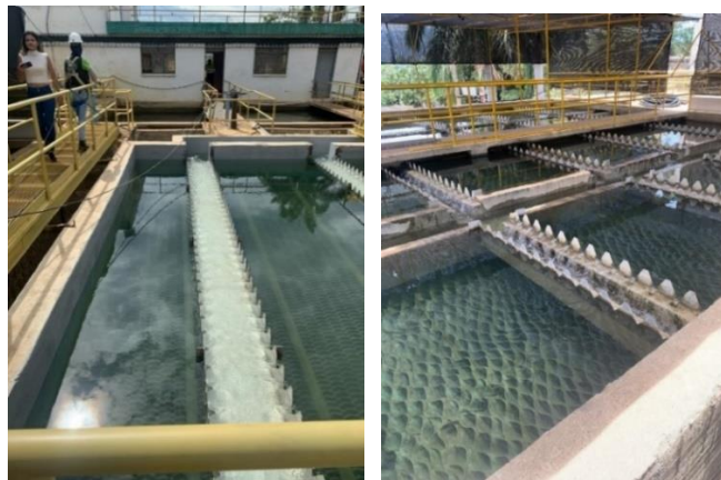
Fotografía No.31 y 32 sedimentador nuevo, y sedimentador existente. Fotografías tomadas el 27 de septiembre
