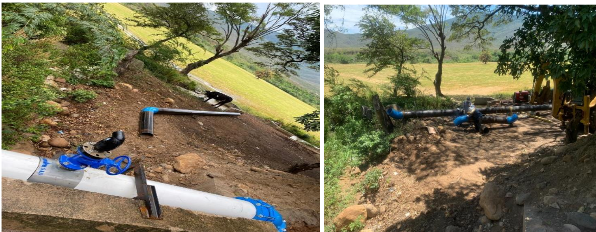
Fotografía No. 3. estado actual paso especial No. 1. Fotografía No. 4. Construcción paso en AC. Fotografías tomadas el viernes, 27 de septiembre
