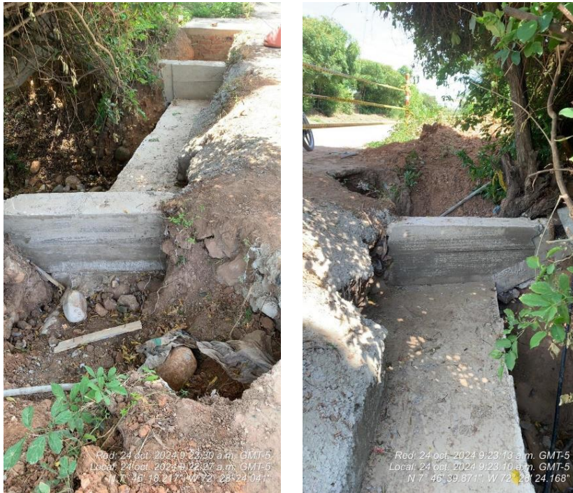
Fotografía No 17. Estado actual paso 1No. 10
