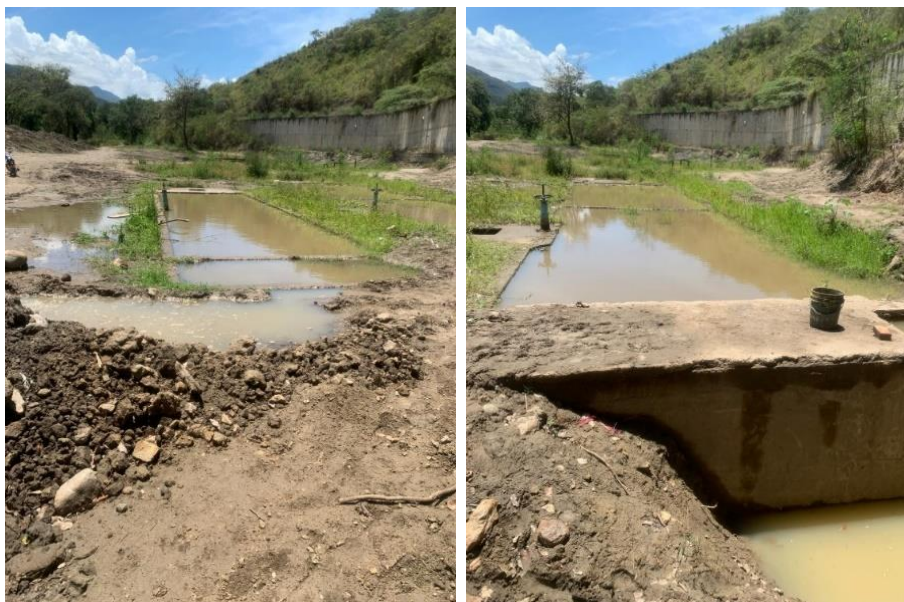
Fotografía No. 1 estado actual desarenador Fotografía No. 2 estado actual empalme desarenador.
